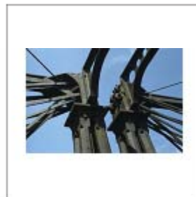
060609-044-MD.jpg Bollman Truss bridge
