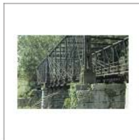
051120-044-MD.jpg Bollman Truss Bridge
